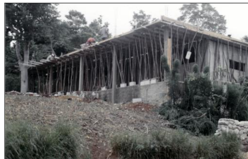
Die Aufstockung auf den Kindergarten
